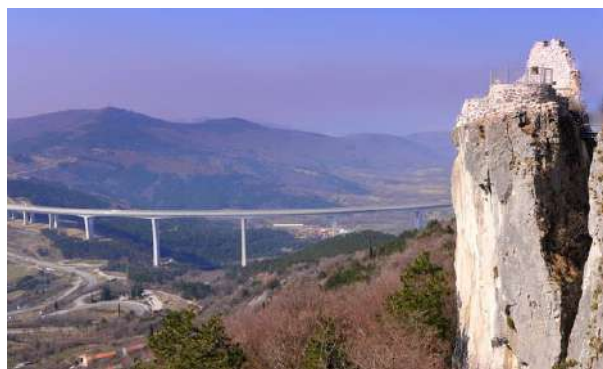
Viadukt Črni Kal, promocijska fotografija poti na visitkoper.si (Arhiv MOK).
